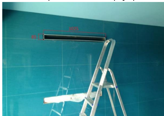
9. Namontování potrubí na kryt 10. Namontování potrubí zarovno s finálním povrchem stěny v bazénové hale
