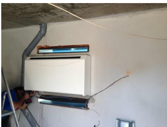
5. Namontování krytu odvlhčovače
