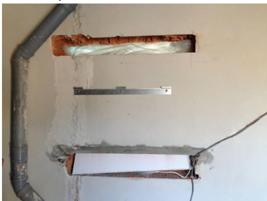
3. Namontování konzoly na stenu
