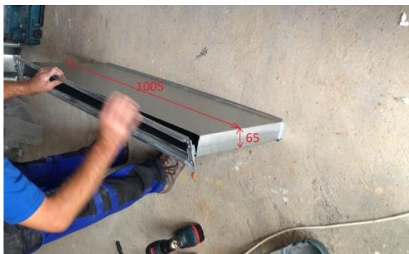
7. Přinýtování příruby na zkrácené potrubí 8. Nalepení těsnění na spoje potrubí
