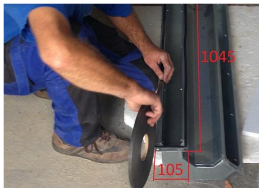
7. Přinýtování příruby na zkrácené potrubí 8. Nalepení těsnění na spoje potrubí
