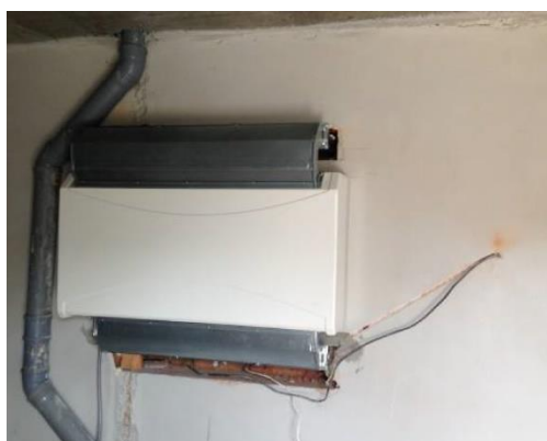
9. Namontování potrubí na kryt 10. Namontování potrubí zarovno s finálním povrchem stěny v bazénové hale
