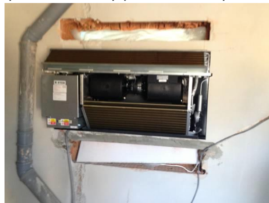
4. Namontování odvlhčovače a zapojení elektrického kabelu a odvod kondenzátu
