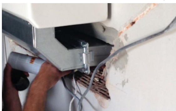
11. Vytěsnění mezer ve zdi PUR pěnou
