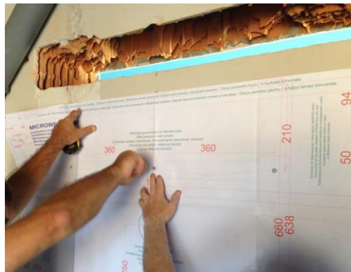
2. vyměření konzoly pomocí šablony
