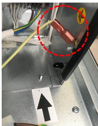
2. odpoj uzemnění kabelu (netahat za drátek)
