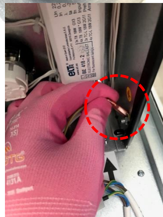
2. odpoj uzemnění kabelu (netahat za drátek)
